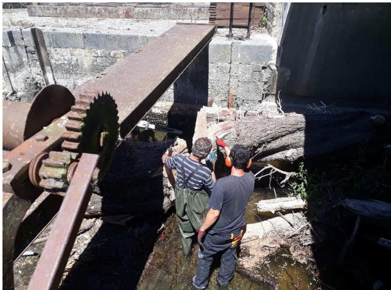
Dans le cas de Saint-Aignan, la manœuvre nécessite aussi la pose de poutrelles sous le pont.
